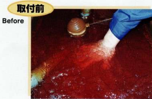
▲工業水系…チラーユニットの赤水改善例。薬剤の投入もストップし、年2回の清掃も不要になりました。
